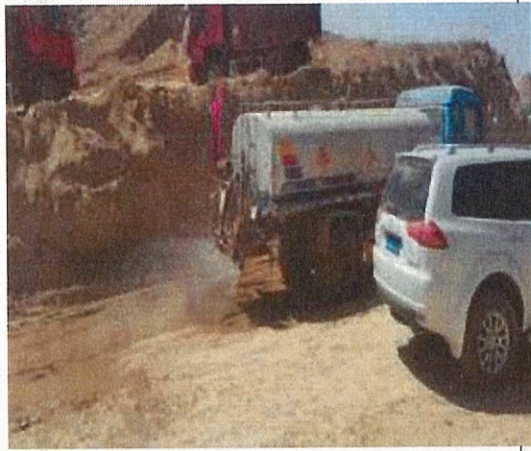
施工便道常态化洒水降尘
