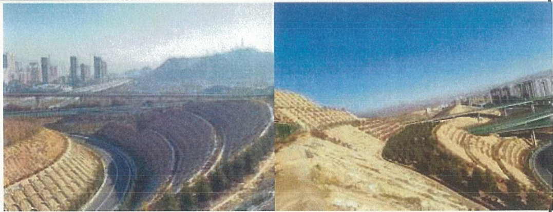
路基表破拱形护坡骨架
