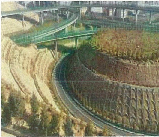
新建 E、F 匝道植被恢复
