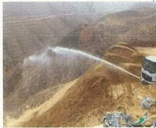
弃渣场边坡洒水降尘
