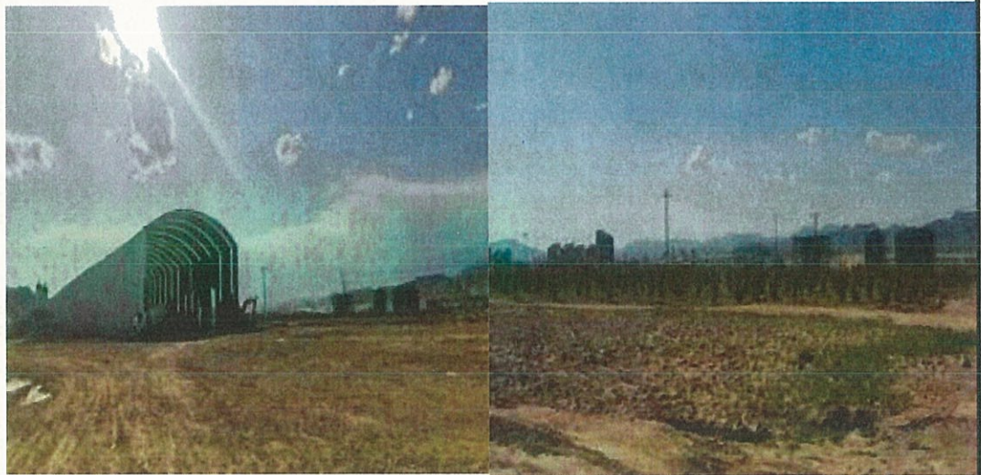
预制场站拆除（恢复中）
